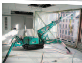
Pose de vitrages
