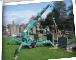
Maçonnerie en pierre
