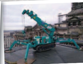
Levage sur toit
